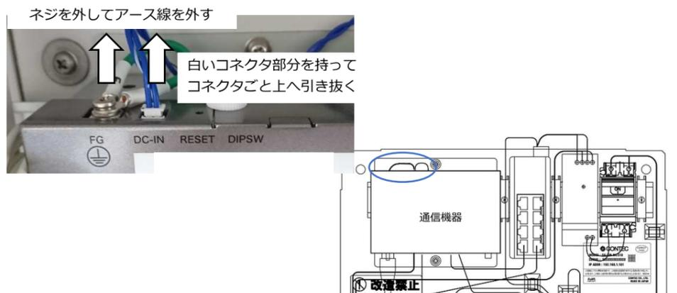
通信機器下部の LAN ケーブルとアンテナを外します。ケーブルを抜き終わったら、取付金具の下を通っているアース線と電源ケーブルを抜いて、通信機器を取付金具ごと BOX から取り出してください。
